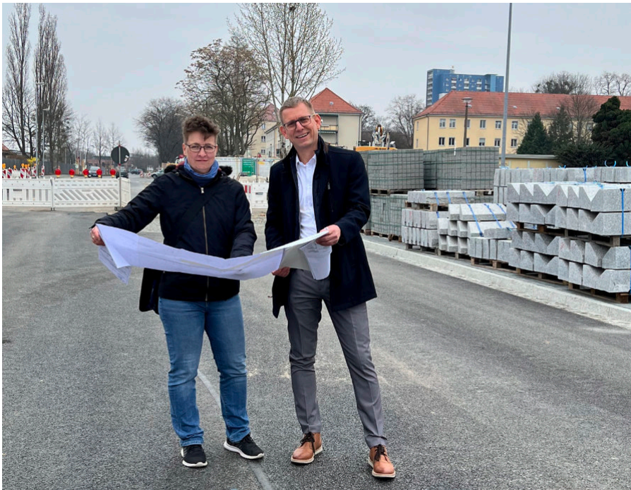
Bürgermeister der Stadt Pirna Markus Dreßler und Fachgruppenleiterin Tiefbau Sandra Roscher begutachten den Baufortschritt auf der Struppener Straße und informieren sich über die nächsten Schritte des Projekts (Foto: Stadtverwaltung)
