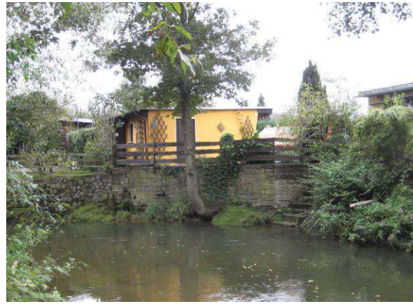
Abb. 8: Parzelle im Gewässerrandstreifen in der Anlage P 117 „Wesenitzau“
