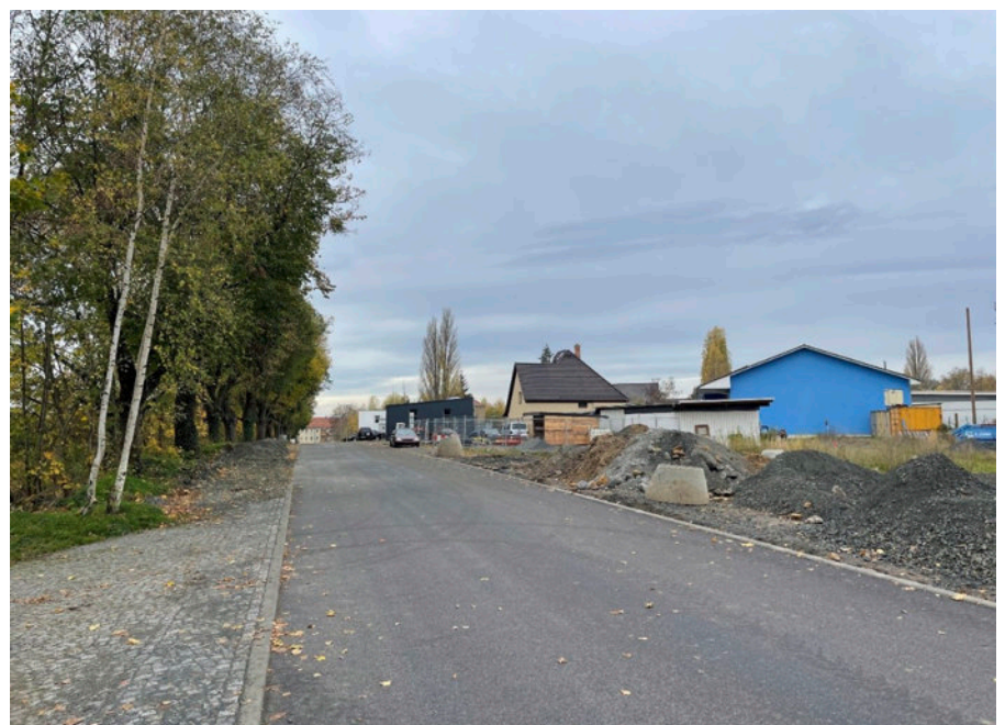
Neue Asphaltfahrbahn am Gewerbegebiet (Foto: SEP)
