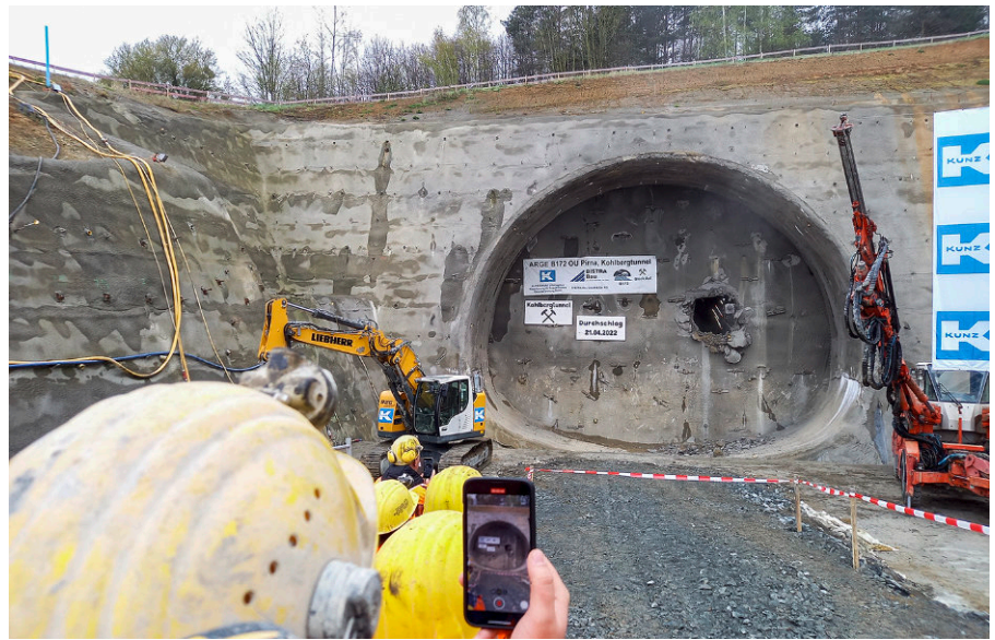
Vom Tunnelanstich am 8. September 2020 bis zum Tunneldurchschlag am 21. April 2022 vergingen reichlich 20 Monate (Foto: DEGES)
